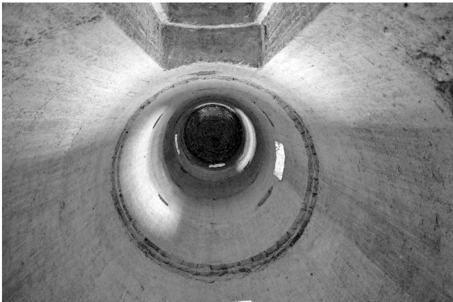
1. Vano presente entro uno dei piloni del tamburo della cupola entro cui doveva essere collocata la scala a chiocciola in muratura, realizzata solo parzialmente.
