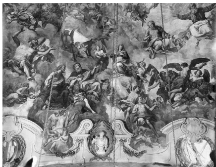
8. Piattaforma lignea interna alla base della calotta, sostenuta da quattro catene in ferro ancorate ai piedi della lanterna, realizzata nel 1913 per l'intervento di restauro. Mantova, Archivio di Stato, Fondo Canneti Enrica, b. 46, album 1, foto 7.
