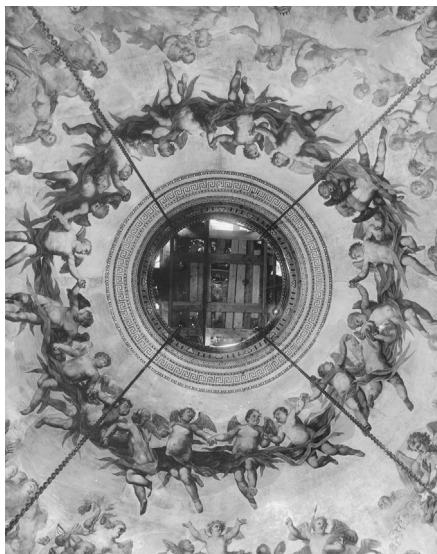
9. Catene in ferro dalla base della lanterna a sostegno della piattaforma lignea interna alla base della calotta, per l'intervento di restauro degli interni iniziato nel 1913. Mantova, Archivio di Stato, Fondo Canneti Enrica, b. 46, album 1, foto 11.
