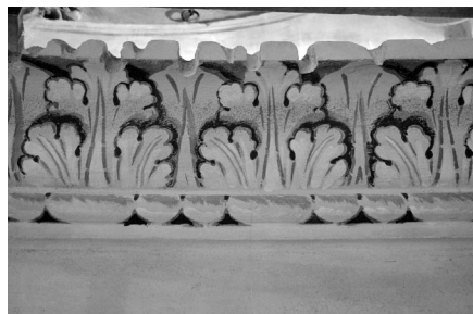
3. Solchi sul listello superiore della cornice lasciati dallo sfregamento delle funi di operatori che si calavano dal piano di calpestio verso le superfici del tamburo.
