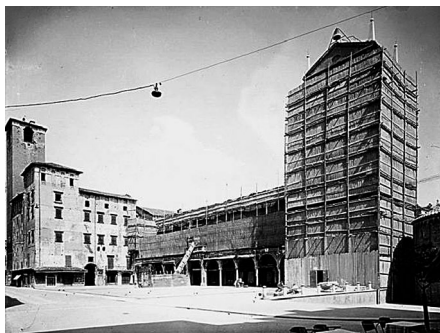
4. In un'ottica di protezione preventiva i ponteggi impiegati durante gli interventi di restauro del Palazzo della Ragione e della Torre dell'Orologio vennero riadattati come difesa antiaerea.
